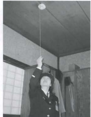
▲住宅用火災警報器の状態を確認しました
