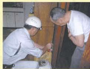
▲コンセントプレートをしっかりと壁に固定し直してくれました
